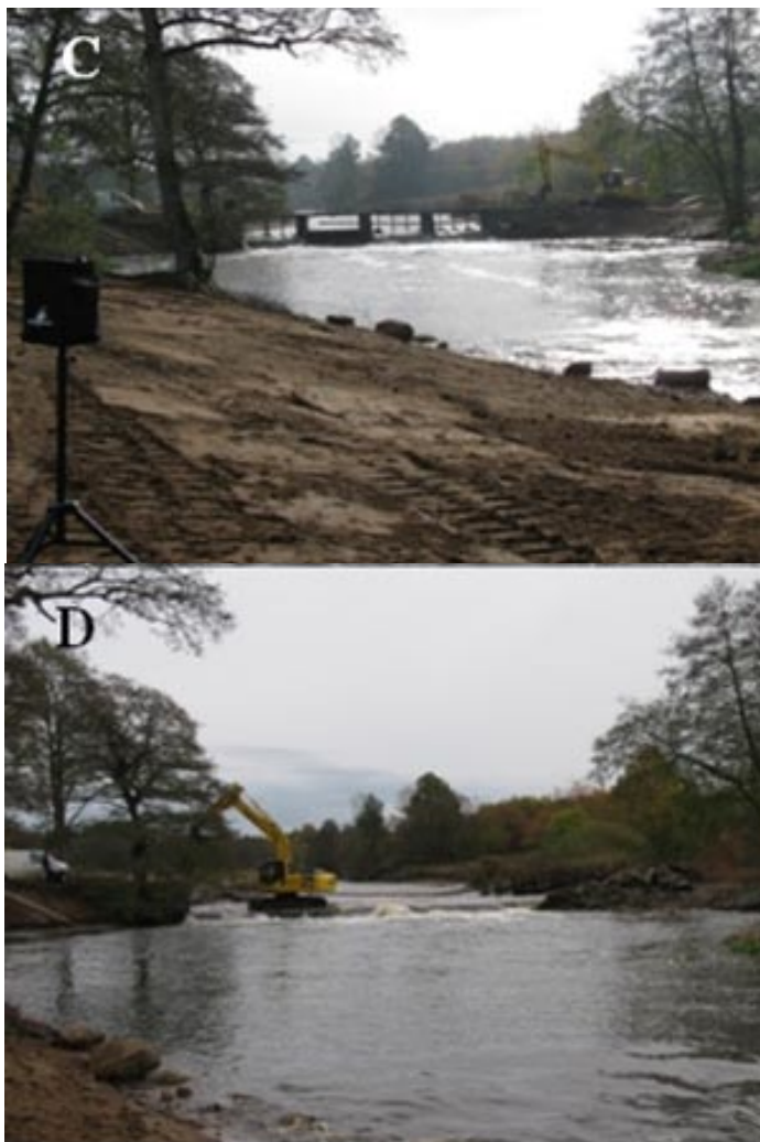
Figur 17 Billederne illustrerer, hvor hurtigt forandringer sker. A viser stemmeværket for et par år siden, hvor vandet stadig løb gennem turbinen. B viser situationen sidste år (2007), efter turbinedriften var indstillet og vandet skulle over stemmeværket. C og D viser situationen en dag i slutningen af oktober 2008 henholdsvis kl. 13.00 og kl. 14.30, - før og efter stemmeværket blev fjernet. Stemmeværket var fra 1866, og naturgenopretningsprojektet har været undervejs i 20 år. Det tog dog kun 90 minutter at fjerne selve stemmeværket. Projektet er finansieret via miljømilliarden (Vand- og Naturindsatsen).
